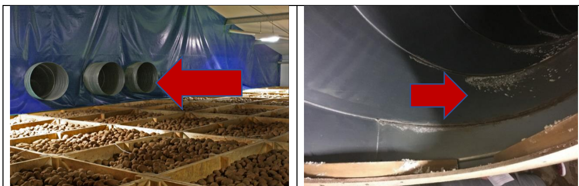
Figuur 4 en 5: Luchtkoeling en luchtgeleidingsbuizen in kistenbewaring.
