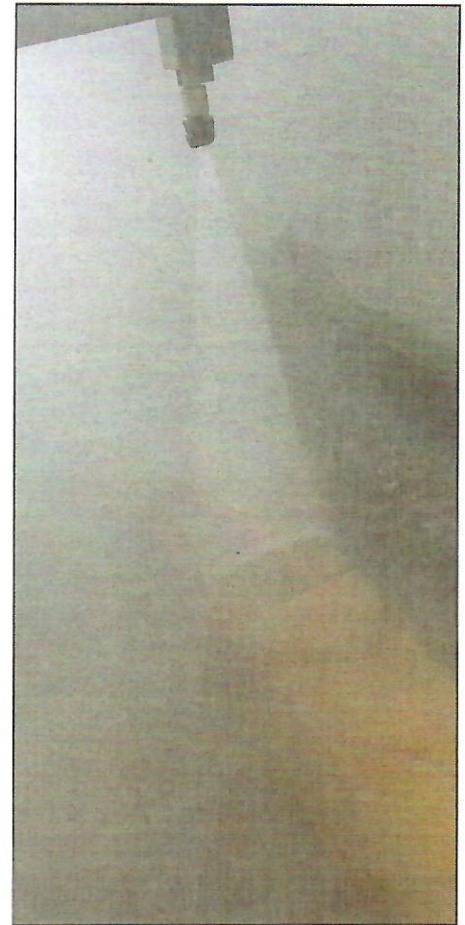
Na vier dagen intrekken van het middel zijn de balken in een proefopstelling gereinigd met een stoomcleaner.
